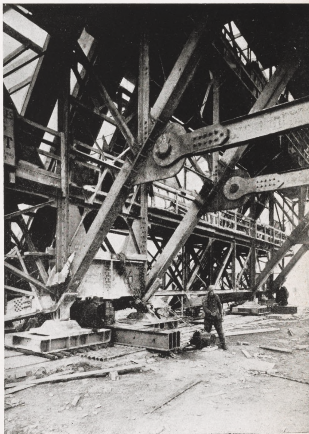
Fig. 112. Le dégagement du cintre de sa fondation. Les tirants horizontaux sont mis sous tension. On procède au soulèvement du cintre au moyen de verins hydrauliques. Une fois dégagée, le cintre sera descendu sur les chariots de roulement que l'on peut voir déjà en place.
