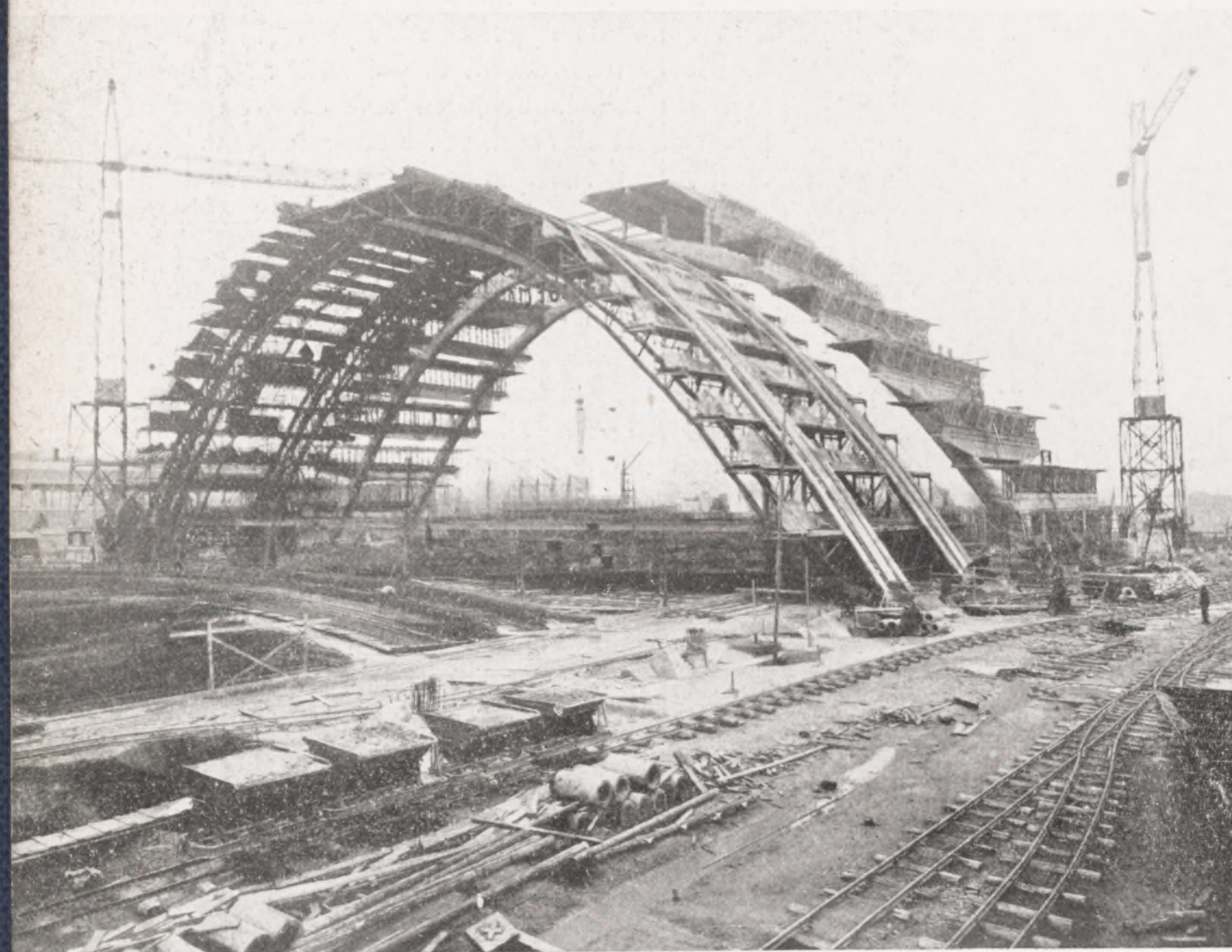
Fig. 110. Le ripage du cintre est achevé; il occupe son normal emplacement.
